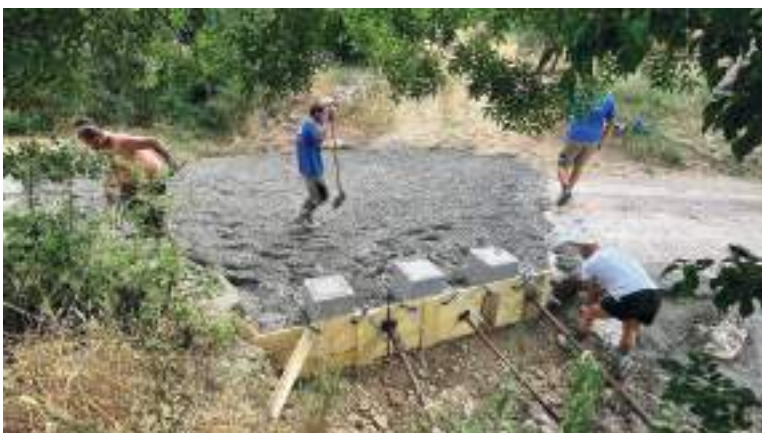
Aménagement d'un passage à gué chemin de St Comès par les agents municipaux.
