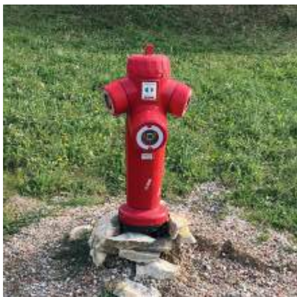
Dans la continuité du travail commencé en 2014, un nouvel hydrant a été remplacé au Foyer d'accueil médicalisé des Massagues.
