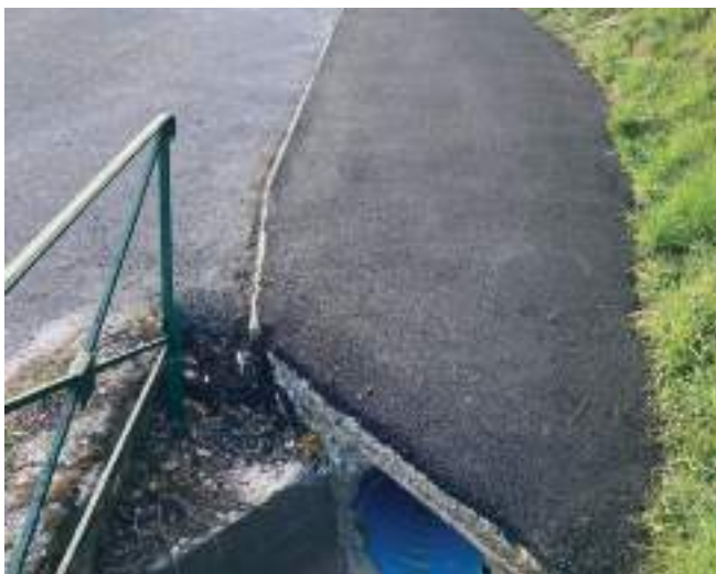
Finalisation du bas-côté de la rue des Écoles pour l'écoulement contrôlé des eaux pluviales.
