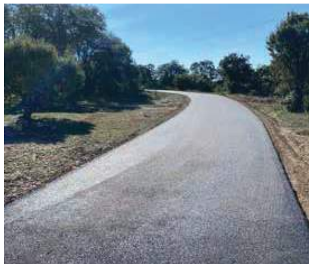
Reprise du chemin rural de Courignone permettant un accès régulier au Foyer d'accueil médicalisé des Massagues.
