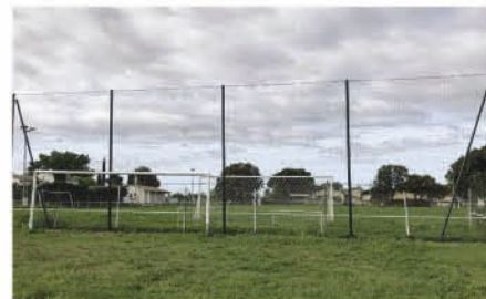
Remplacement des filets de protection au stade de foot.
