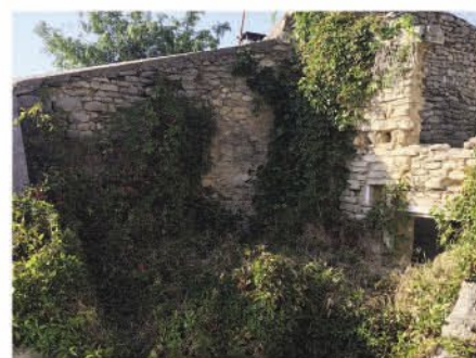
Achat d'un terrain à l'arrière de l'église permettant la mise en sécurité des bâtiments les plus fragiles du village et la possibilité d'envisager des projets d'aménagement de la zone.
