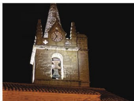
Éclairage du clocher de l'église.
