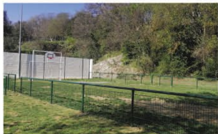
Installation d'un city stade au Parc de la Garenne avec la construction d'un mur d'entraînement sur le terrain de tennis.
