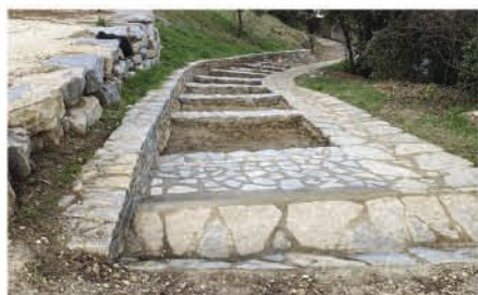
Réfection de la descente des écoles grâce à un chantier d'insertion.
