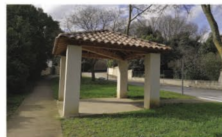
Création d'un nouvel abribus rue des écoles. Les bancs y seront ajoutés en 2021.
